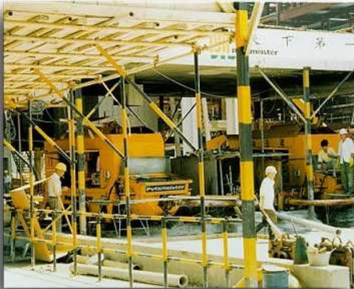
Die beiden BSA 14000 waren an hochdruckfesten ZX-Förderleitungen angeschlossen
