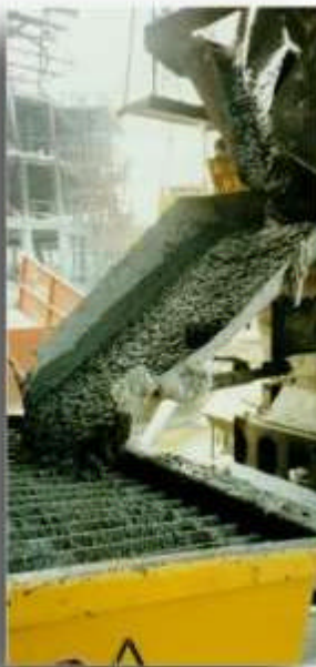
Pumpen von Betonsorten unterschiedlicher Festigkeit
