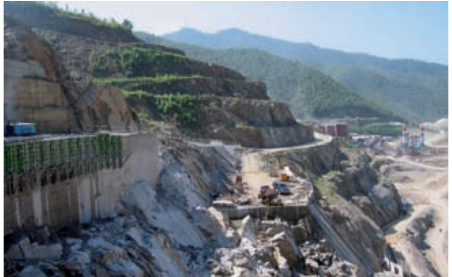
Vor dem Dammbau waren umfangreiche Erdarbeiten erforderlich
