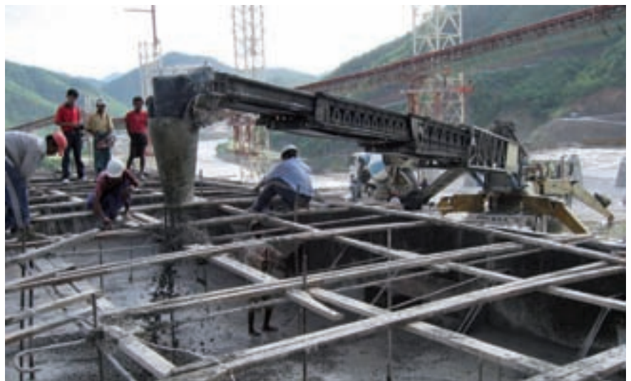
Der Telebelt fördert die unterschiedlichsten Baustoffe – Sand, Schotter und erdfeuchte RCC-Mischungen, genauso wie „normale“ Betonrezepturen
