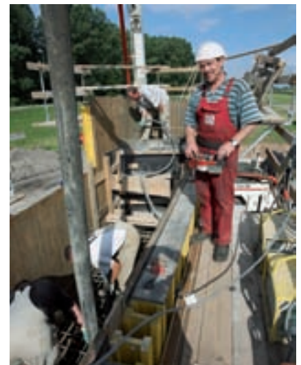
Beim Betonieren der engen Bewehrung befindet sich der Maschinist möglichst nahe der Einbaustelle
