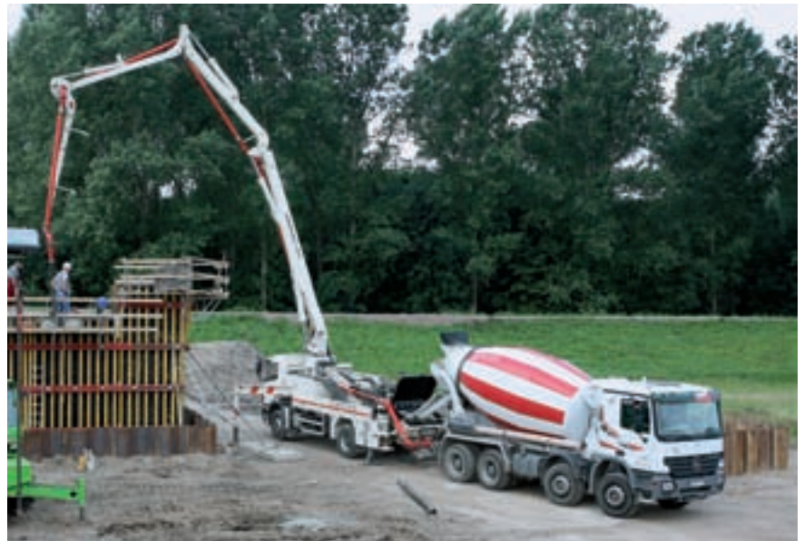
Bei jedem Brückenbauabschnitt verfügen die Betonpumpen der BFU über die passende Verteilmastgröße – hier ein M 24-4
