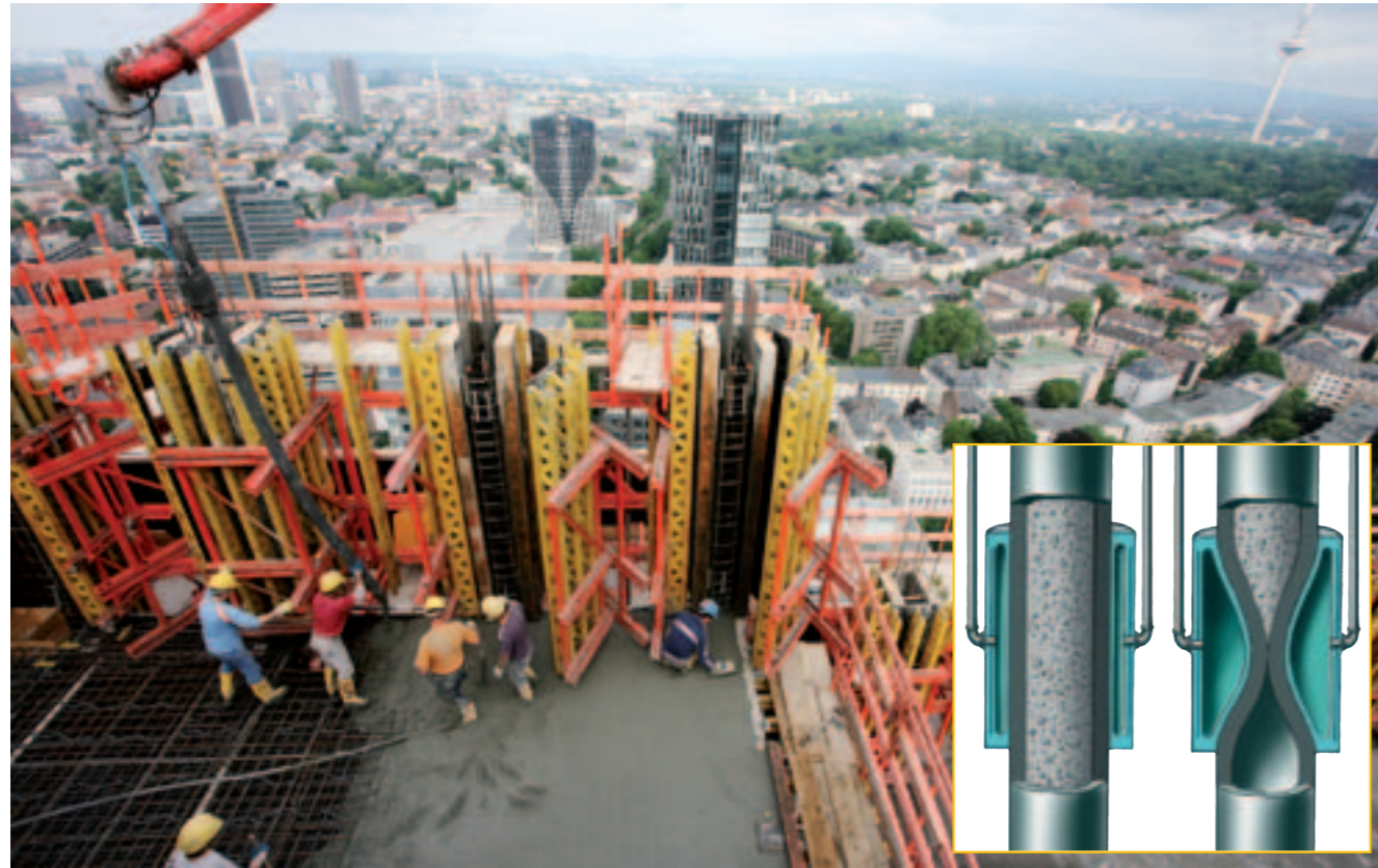
Bei der Betonage der Geschosse wurden hoch über Frankfurt ca. 100 bis 120 m 3 Beton in drei Stunden eingebaut
