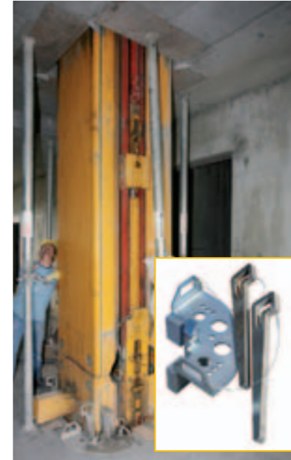
Leicht umzusetzende Deckenführungen geben der Rohrsäule des MX-Mastes seitlichen Halt
