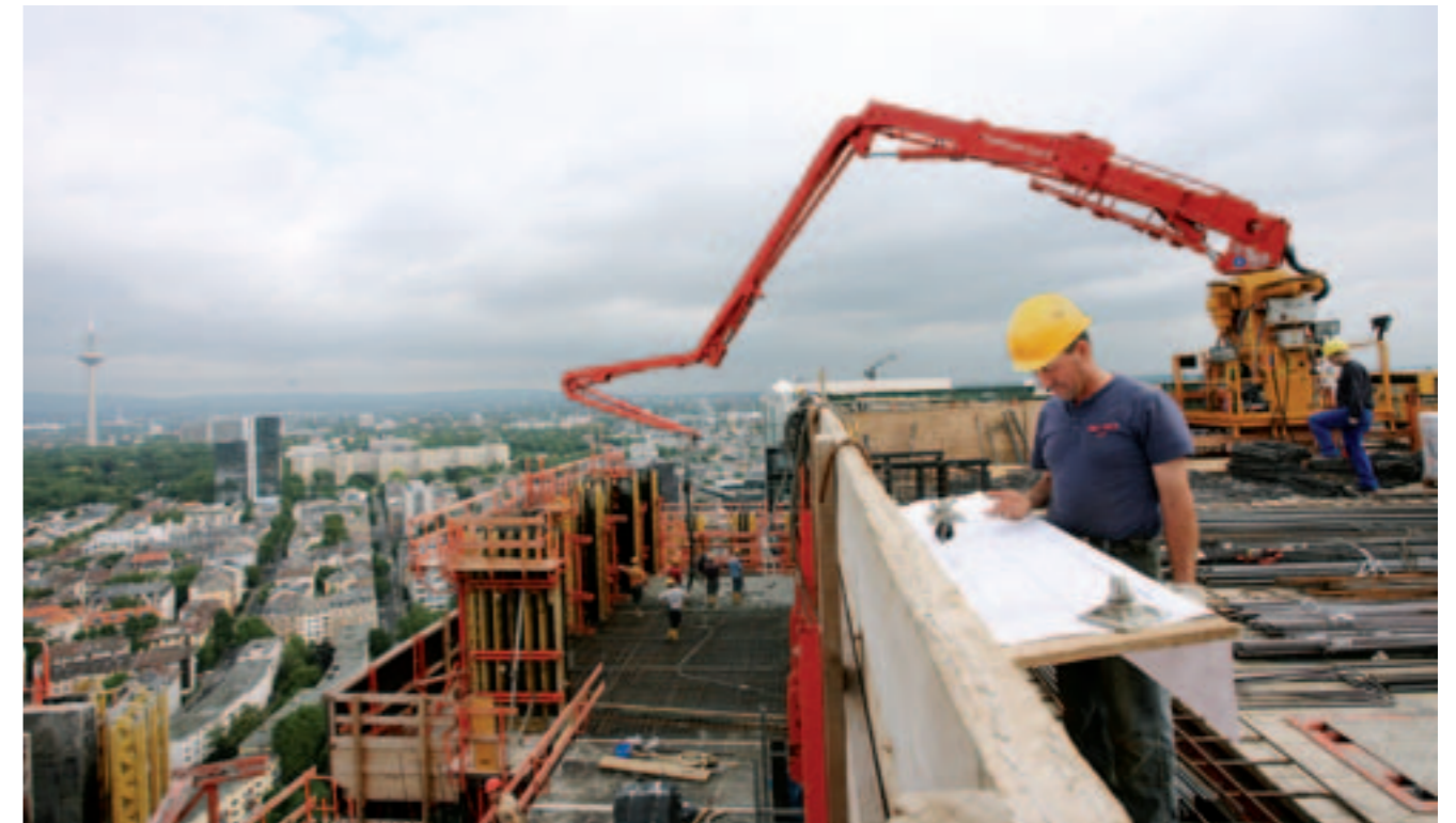
Von erhöhter Position aus verteilt der PM Stationärarm den Beton auch in schwer erreichbare Abschnitte der Deckenschalung
