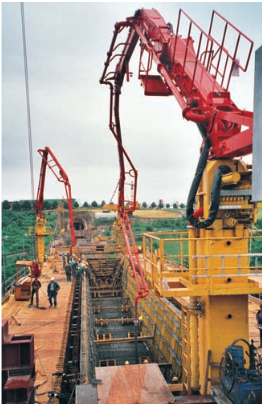
Die beiden Stationärmaste MXR 32 (vorn) und MXR 24 beim Betonieren des Brückentrgs
