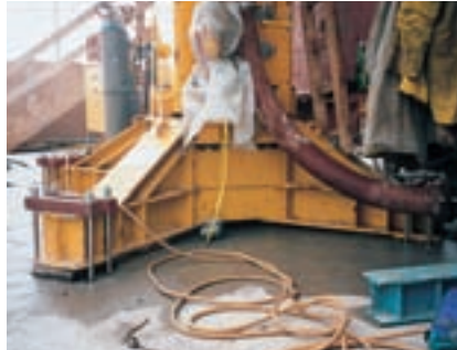
Befestigung des MXR 32 auf fertig betoniertem Deckenabschnitt
