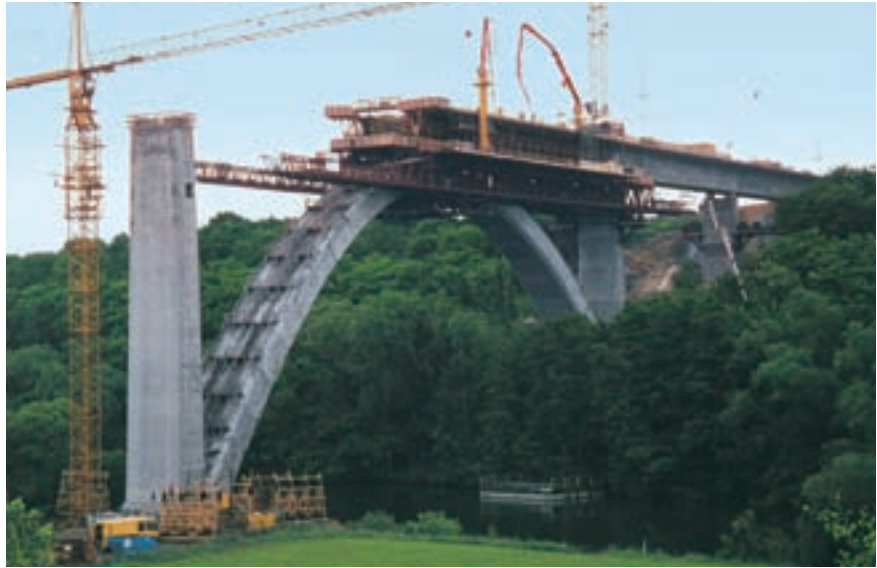
Betonierung der Lahntalbrücke mit Vorschubrüstung
