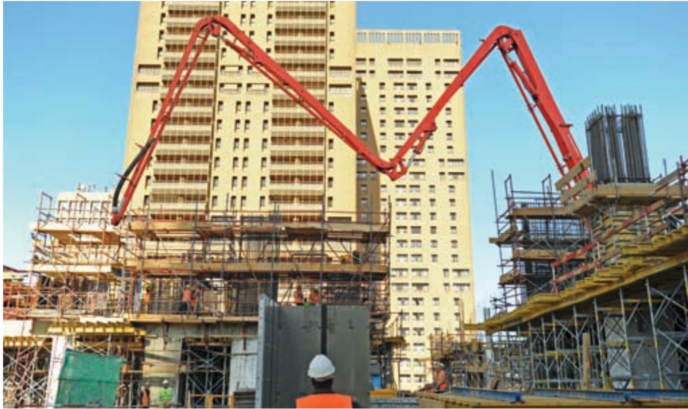
▲ Hydraulischer Betonverteilmast MX 36-4
